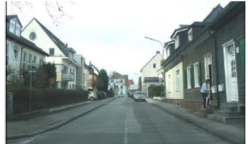
Bild 8: Foto Martin-Luther-Straße (Blick nach Norden)
