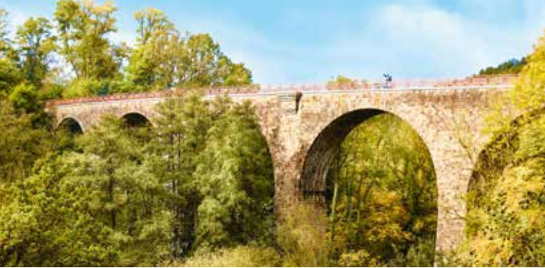
Viadukt Ruhrstraße, Heiligenhaus
