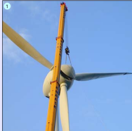
1./2. Montage von Kopf und Rotor 3. Windkraftanlage mit Müllheizkraftwerk im Hintergrund
