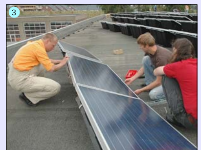
1. 54 kWp-PV-Anlage auf dem Dach des Berufskollegs in Velbert (2008) 2. Drei Generationen von PV-Anlagen eines privaten Bauherrn in Ratingen 3. Aufbau der 21 kWp-PV-Anlage auf dem Dach des Kreisbauhofs in Mettmann (2007)
