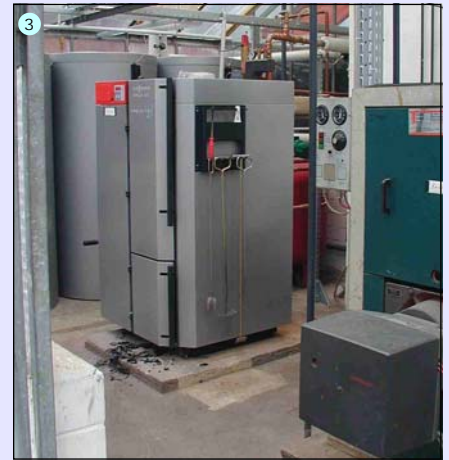
Fotos: Stadt Remscheid, Gebäudemanagement
