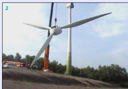
1./2. Montage von Kopf und Rotor 3. Windkraftanlage mit Müllheizkraftwerk im Hintergrund
